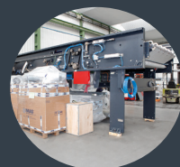
Réinstallation de machines
